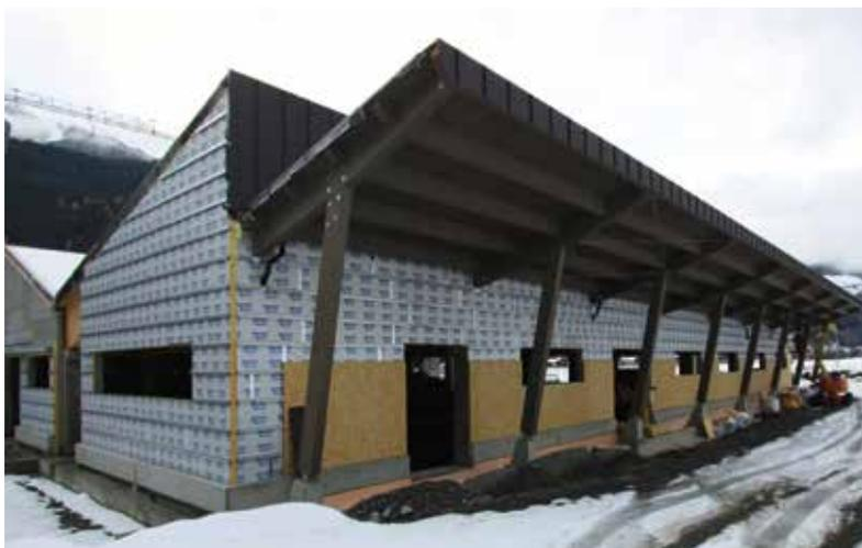
Tale soluzione è stata privilegiata per la sua versatilità e velocità di realizzazione poiché consente, con un unico passaggio di posa, di creare sia un efficace strato di isolamento termico continuo ad elevate prestazioni, che la camera di ventilazione e la sottostruttura per accogliere, sostenere e consentire il fissaggio del
