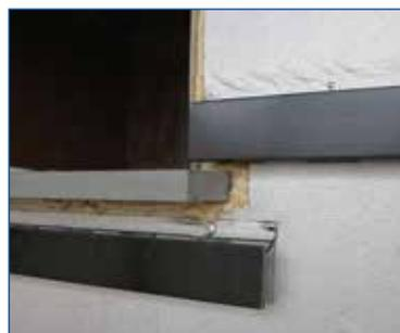
La progettazione esecutiva delle facciate è stata curata dallo studio MudiLab di Monza, che ha prestato grande attenzione ad ogni dettaglio, in cui il pacchetto isolante Isotec (nella versione Parete e Linea) viene collegato con gli elementi architettonici della facciata tramite l'utilizzo di lamiera piegata. Possiamo notare a titolo esem-
