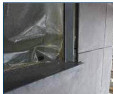
plificativo la risoluzione del nodo finestra, la realizzazione di imbotti in lamiera piegata (lati e voltino) e il collegamento al davanzale in pietra (dettaglio 1); per gli angoli della facciata sono state impiegate lamiere di spessore 3 mm, mentre nel dettaglio 4 si apprezza il collegamento fra la soluzione ventilata e non ventilata della facciata.
