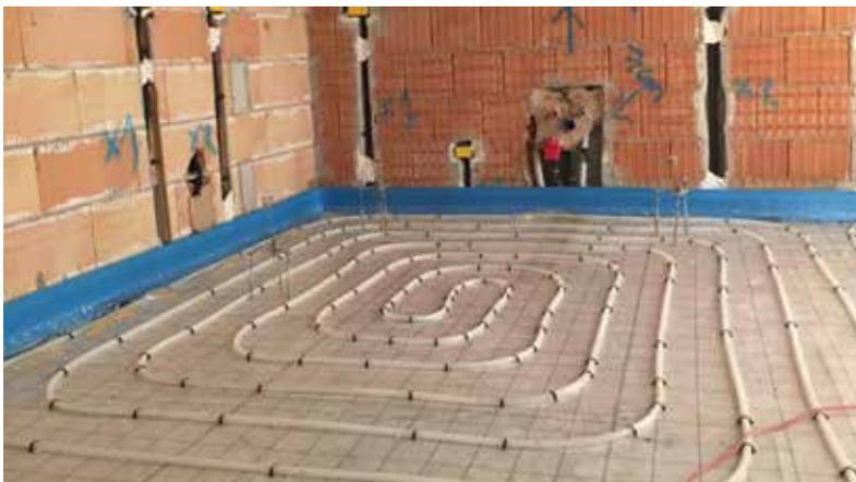
ducibilità termica dichiarata  $-\lambda$  pari a 0,022 W/mK. Anche per la copertura è stata quindi prevista una resistenza termica notevole, 12 m<sup>2</sup>K/W, assicurata da soli 250 mm di isolante poliuretano. Diverse sono le tipologie di pannelli adottate per l'isolamento di fondazioni e solai dell'edificio.
