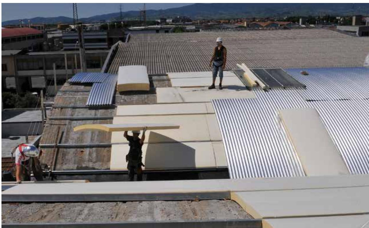
Nella maggior parte delle applicazioni degli isolanti termici in edilizia il formato regolare e la compattezza dei pannelli in poliuretano espanso rigido costituisce un importante vantaggio che rende più veloci e più sicure le operazioni di messa in opera.
