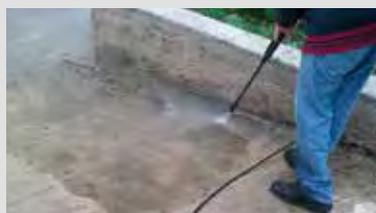
Verifica e pulizia del piano di posa e verifica della tenuta e dello stato generale di un eventuale manto impermeabile preesistente
