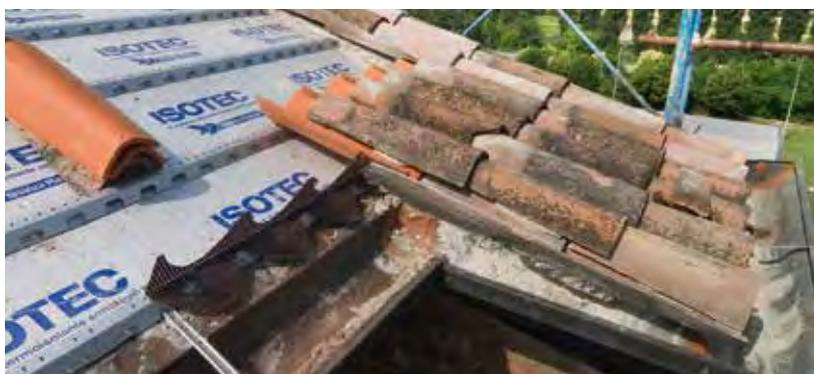
piovane all'interno dell'edificio causate dalla compromessa funzionalità della membrana impermeabile ardesiata applicata, una trentina di anni fa, al di sotto del manto di copertura in coppi.
