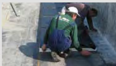
Posa e fissaggio meccanico del primo elemento pendenzato di partenza in prossimità del perimetro, corredato da un eventuale elemento metallico di contenimento.
