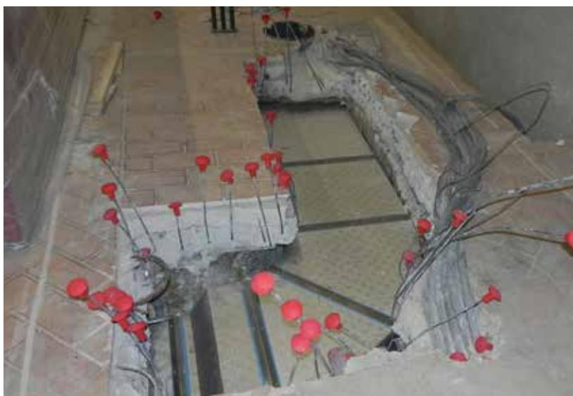
micron, il canale P3ductal risponde perfettamente anche a questa particolare modalità di posa in opera.
