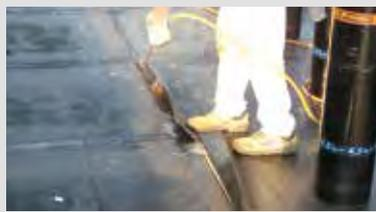
Saldatura delle sormonte della membrana (nel caso di Pendenza Isoplan PUR).
