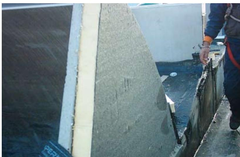
una membrana SBS da 3kg/m<sup>2</sup> che costituisce la prima impermeabilizzazione di quest'area di copertura.
