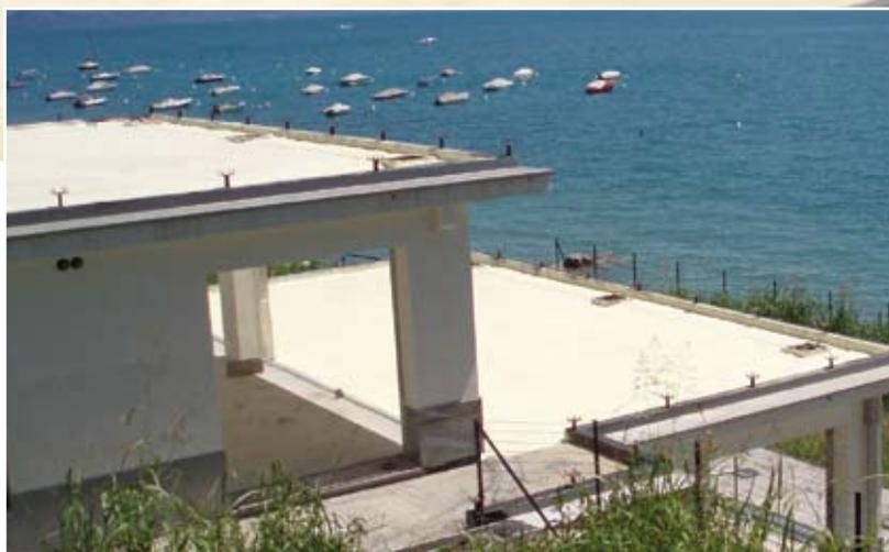
Per la copertura piana e la terrazza sottostante di un nuovo residence con affaccio diretto sulle rive del Lago di Garda, è stato realizzato un isolamento termico in schiuma poliuretana, applicata a spruzzo dalla società Ranghetti Art Proget di Cortenuova (BG).
