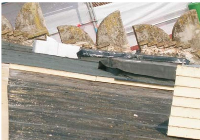
bitumata e polipropilenata che agevola l'adesione tra isolante e manto impermeabile ed è particolarmente resistente alle operazioni di sfiammatura delle membrane.
