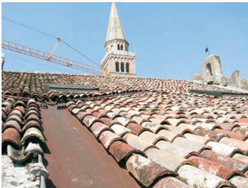
al di sopra della gettata, l'ingombro tecnico della camera di ventilazione sommato a quello dello spessore del materiale isolante, avrebbe modificato l'altezza della copertura con una evidenza in parte visibile dal prospetto dell'edificio.
