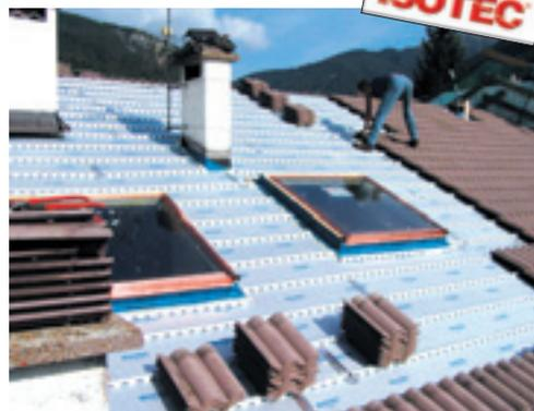
Isotec è predisposto per ricevere qualsiasi tipo di copertura: coppi, tegole in laterizio, tegole in cemento, lastre metalliche, lastre in plastica o in fibrocemento.
