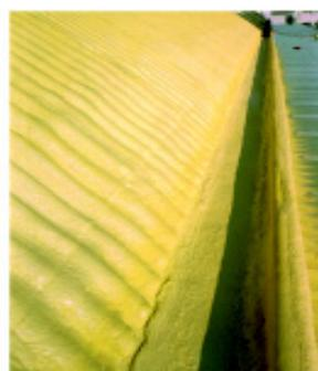
Puretan 50 è un poliuretano a celle chiuse ad alta densità che impermeabilizza ed isola contemporaneamente. È un rivestimento continuo applicabile nello spessore desiderato. È ottenuto mediante spruzzatura in luogo con macchine ad alta tecnologia.
