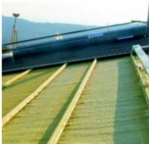
nolitico, privo di ponti termici, correttamente dimensionato per smorzare gli sbalzi di temperatura tra interno ed esterno ed impedire la formazione di condensa sull'intradosso della copertura.
