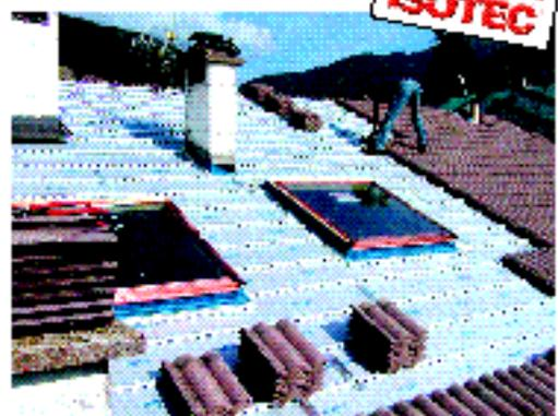
Isotec è predisposto per ricevere qualsiasi tipo di copertura: coppi, tegole in laterizio, tegole in cemento, lastre metalliche, lastre in plastica o in fibrocemento.
