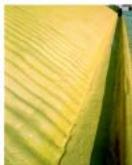
Puretan 50 è un poliuretano a celle chiuse ad alta densità che impermeabilizza ed isola contemporaneamente. È un rivestimento continuo applicabile nello spessore desiderato. È ottenuto mediante spruzzatura in luogo con macchine ad alta tecnologia.
