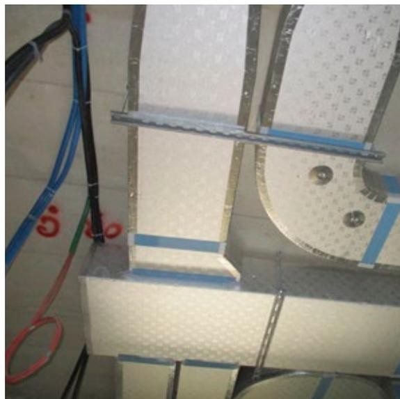
Sul fronte energetico, P3ductal assicura sia un elevatissimo isolamento termico continuo e costante, con valori di conduttività termica  $\lambda_1 = 0,022 \text{ W/(m } ^\circ\text{C)}$ , e sia un'elevata tenuta pneumatica. A differenza dei canali tradizionali, infatti, la metodologia costruttiva P3ductal e il sistema di flangiatura eliminano le perdite longitudinali e limitano quelle trasversali, ottenendo la classe "C" di tenuta pneumatica prevista dalla norma UNI EN 13403.
