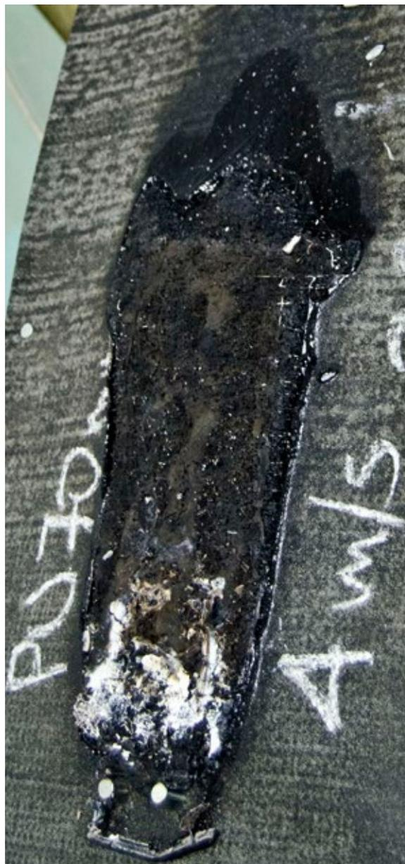
*Un particolare della carbonizzazione superficiale dello strato isolante in poliuretano posto al di sotto del manto impermeabile.*
