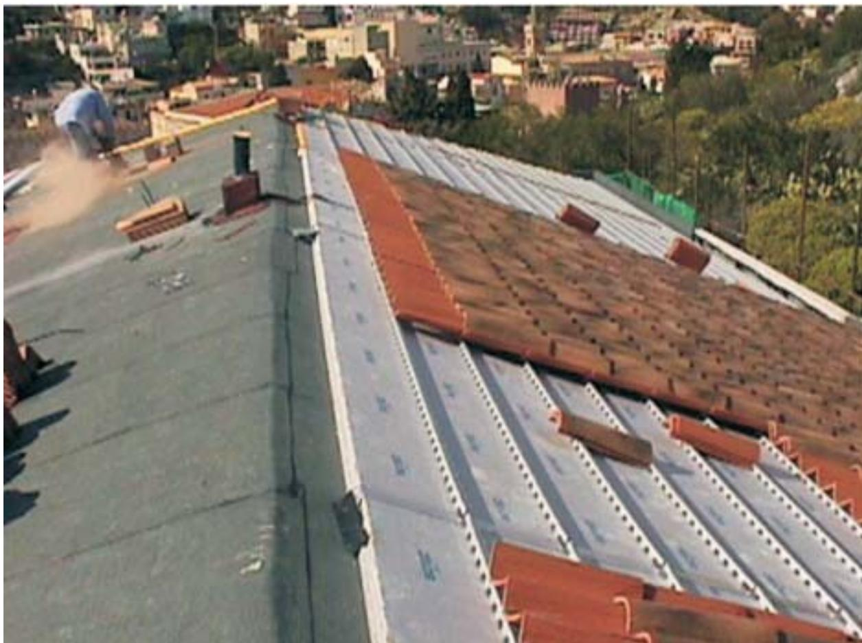
che ha in realtà consentito di ottenere, oltre ad un'efficace coibentazione e microventilazione della copertura, anche un'impermeabilizzazione discontinua sottotegola, comunque utile allo smaltimento in gronda di eventuali, localizzate, infiltrazioni accidentali del manto di copertura ed un'adeguata barriera al vapore.
