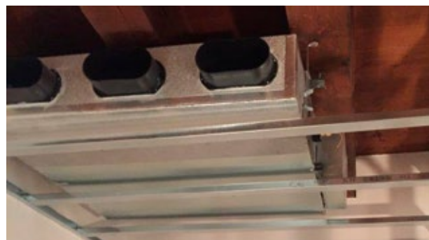
Cassetta di miscelazione realizzata in pannelli in poliuretano rivestiti in alluminio.
