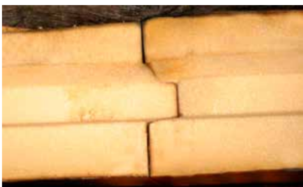
3. L'accostamento tra i pannelli con battentatura laterale.
