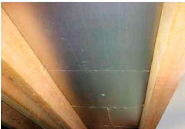
1. Intradosso del tetto a falde con lo strato isolante a vista tra i travetti.
