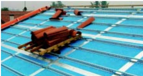
Il pannello, in schiuma Polyiso, ha le dimensioni di 1200 x 1020 mm ed è prodotto negli spessori standard di 50, 60, 80 e 100 mm, con battentatura laterale.
