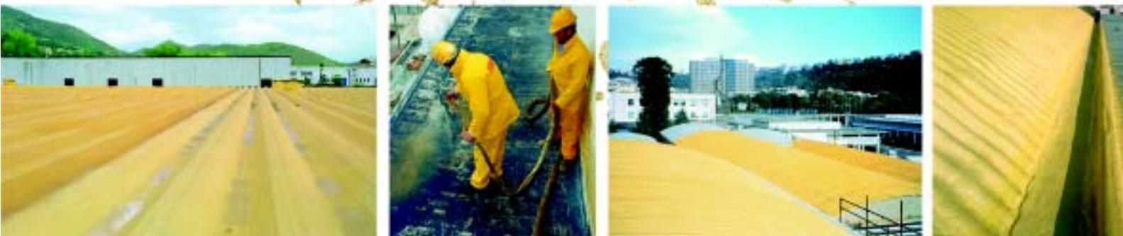
Puretan 50 è un poliuretano a celle chiuse ad alta densità che impermeabilizza ed isola contemporaneamente. È un rivestimento continuo applicabile nello spessore desiderato. È ottenuto mediante spruzzatura in luogo con macchine ad alta tecnologia.
