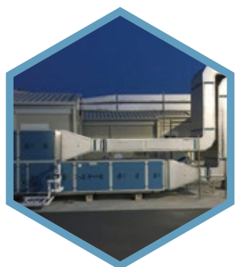
Strutture sanitarie modulari Campania
