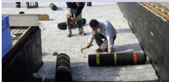
Impermeabilizzazione dei corpi verticali con saldature sul piano orizzontale
