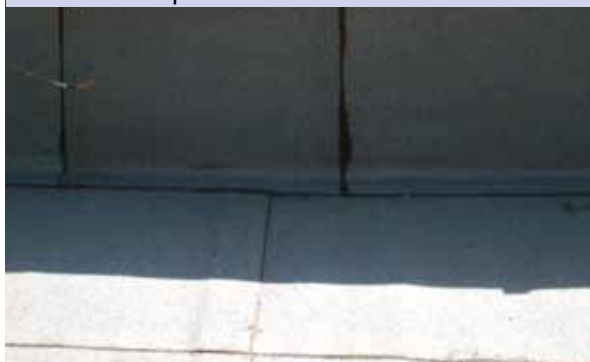
Impermeabilizzazione dei corpi verticali con saldature sul piano orizzontale
