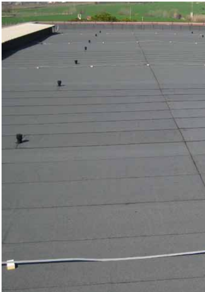
La copertura ultimata con i camminamenti per raggiungere gli impianti
