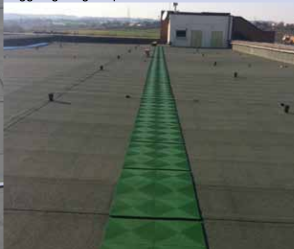
La copertura ultimata con i camminamenti per raggiungere gli impianti
